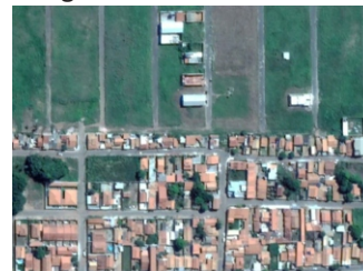
Figura 35 - Descontinuidade entre vias de loteamentos antigos e novos
