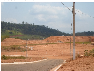
Figura 27 - Terraplenagem em área com relevo ondulado para implantação de novo loteamento
