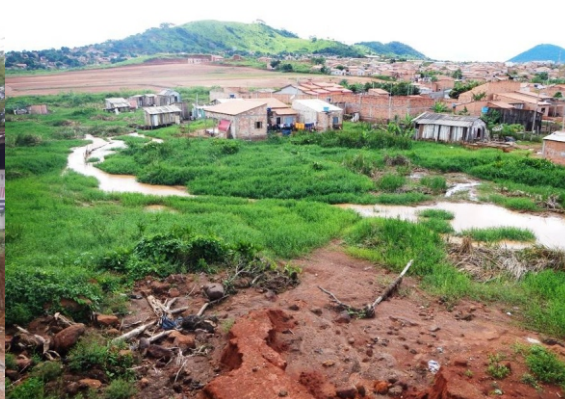
Figura 22 - Área de Risco 4
