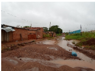
Figura 26 - Aterro identificado às margens de um córrego
