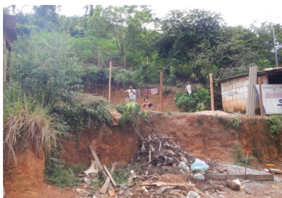
Figura 21 - Área de Risco 3
